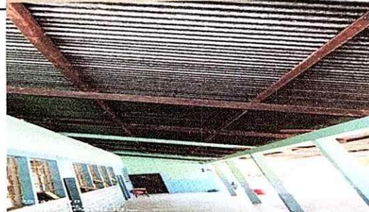
Foto 4: Sustitución estructura de techo
